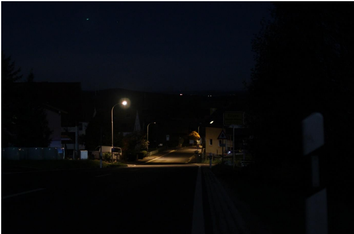
Abbildung 1: Aufnahme Ortseingang Elters von Steens kommend. Im Vordergrund noch eine alte Kofferleuchte – dahinter die umgerüsteten Leuchten. Deutlich zu sehen ist, dass das Licht nun gezielt auf die Straßenfläche gelenkt wird. Foto: Christian Hillenbrand
