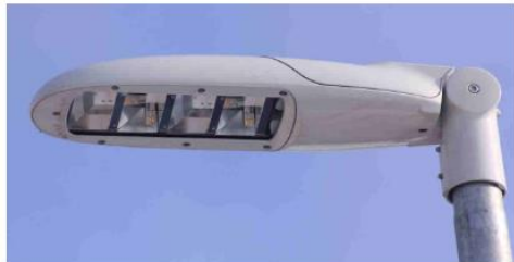
Abb. 10 + 11: Detailaufnahmen zeigen die asymmetrische Anordnung der LED, die zu einer relativ blendfreien Beleuchtung führt.
